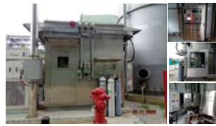
ระบบ Continuous Emission Monitoring (CEMs)
